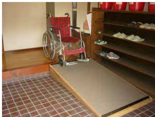
【写真2 自治会館入口の段差解消】
